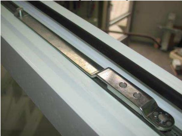
Bild 21 Zusatzschere, Flügelrahmen
