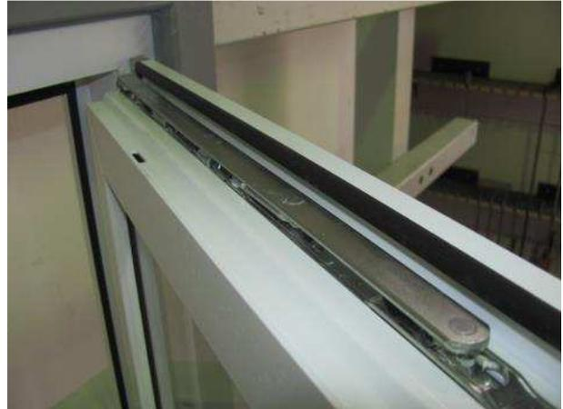
Bild 8 Scherenlager, Falzansicht Flügelrahmen
