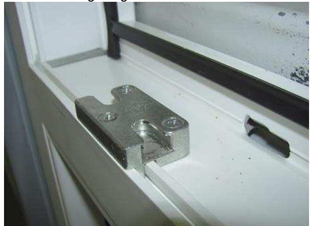
Bild 16 Verriegelungssituation Blendrahmen 2
