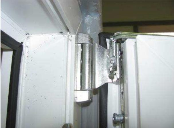
Bild 7 Scherenlager, Falzansicht Blendrahmen
