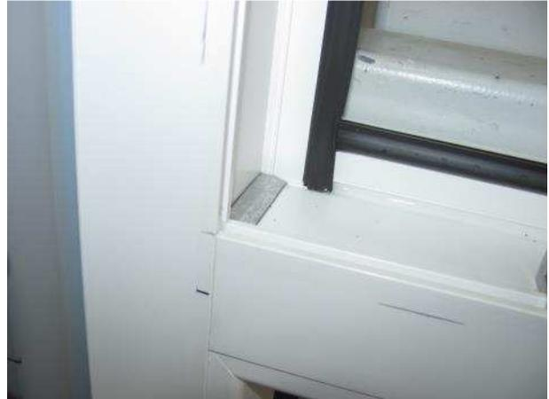
Bild 2 Äußere Anschlagdichtung, Eckausbildung
