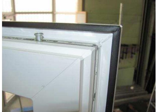
Bild 4 Innere Anschlagdichtung
