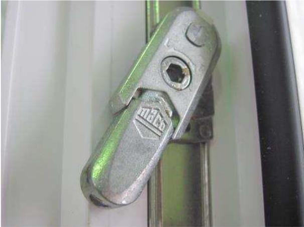
Bild 19 Fehlbedienungssperre, Flügelrahmen
