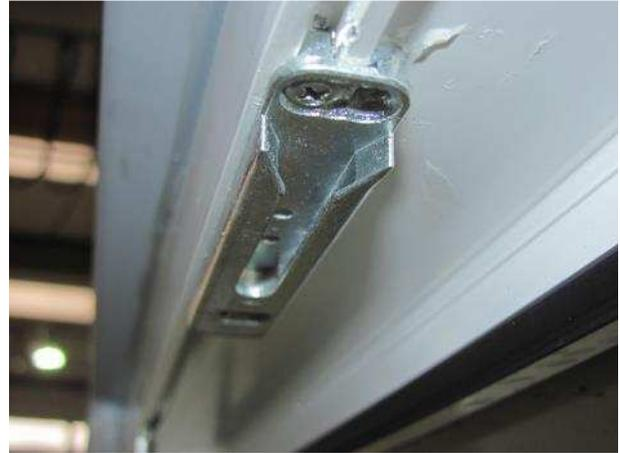
Bild 20 Zusatzschere, Blendrahmen
