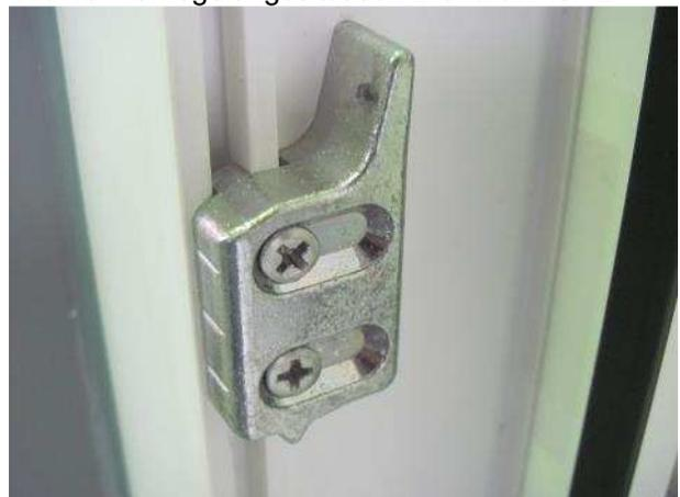
Bild 18 Fehlbedienungssperre, Blendrahmen
