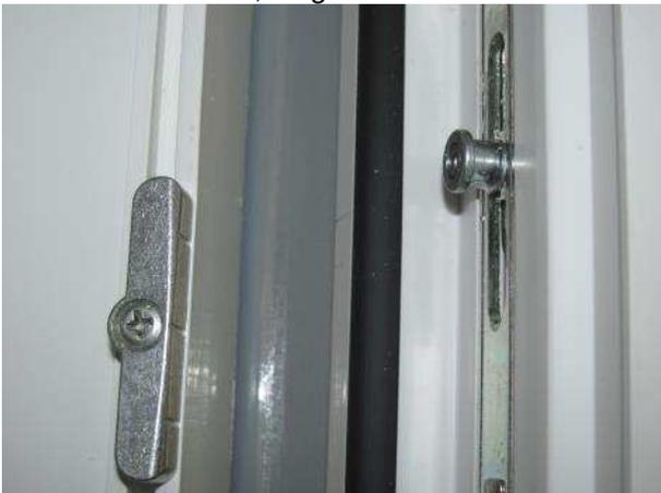
Bild 15 Verriegelungssituation Flügelrahmen 1
