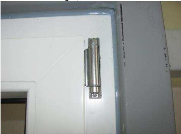
Bild 9 Scherenlager, Ansicht innen
