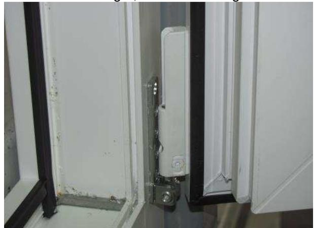
Bild 10 Ecklager, Falzansicht Blendrahmen
