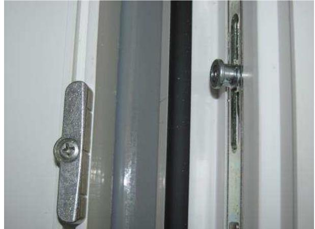
Bild 14 Verriegelungssituation Blendrahmen 1
